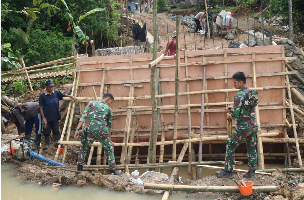
Serang - Salah satu Sasaran Fisik TNI Manunggal Membangun Desa (TMMD) Ke 119 Kodim 0602/Serang, yaitu pembuatan jembatan menjadi akses utama penghubung pembukaan jalan sepanjang 507 (Lima Ratus Tujuh) Meter, memasuki hari ke 14 (Empat Belas) proses pengerjaannya terus di kejar, saat ini sudah memasuki tahap pembuatan pondasi sekitar 35 (Tiga Puluh Lima) Persen, bertempat Di Kampung Cisolak Desa Bojong Pandan Kabupaten Serang Provinsi Banten, Senin (04/03/2024).
